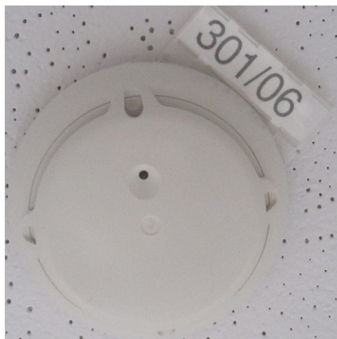
Abbildung 6: Beispiel für Kennzeichnung auch am Melder
